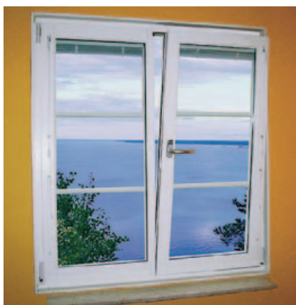
B – Dreje/kip under ventilation.
